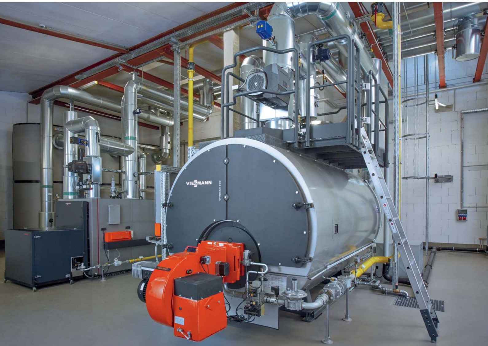
Heißwasserkessel Vitomax 300-LW (2300 kW) und links ein Niedertemperatur-Heizkessel Vitoplex 200 (700 kW)
