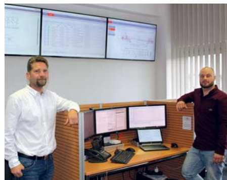
Leitwarte zum Online-Monitoring aufgeschalteter Energieanlagen im größeren Leistungsbereich
