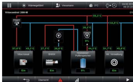
Zentrale Visualisierung von Mehrkesselanlagen
